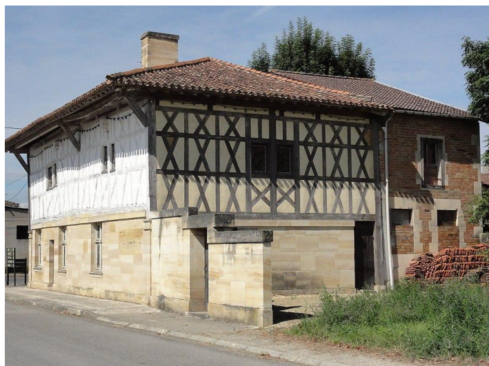
Figure 11 – Maison à pans de bois
