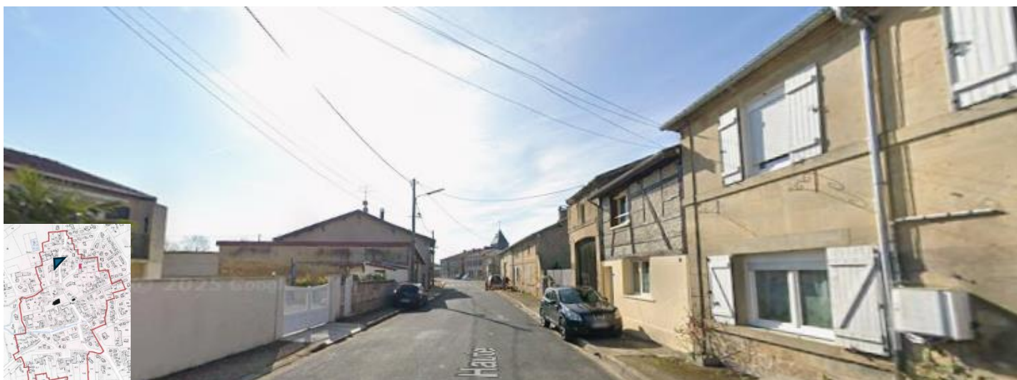
Figure 16 : Les alignements de constructions traditionnelles sont à préserver
