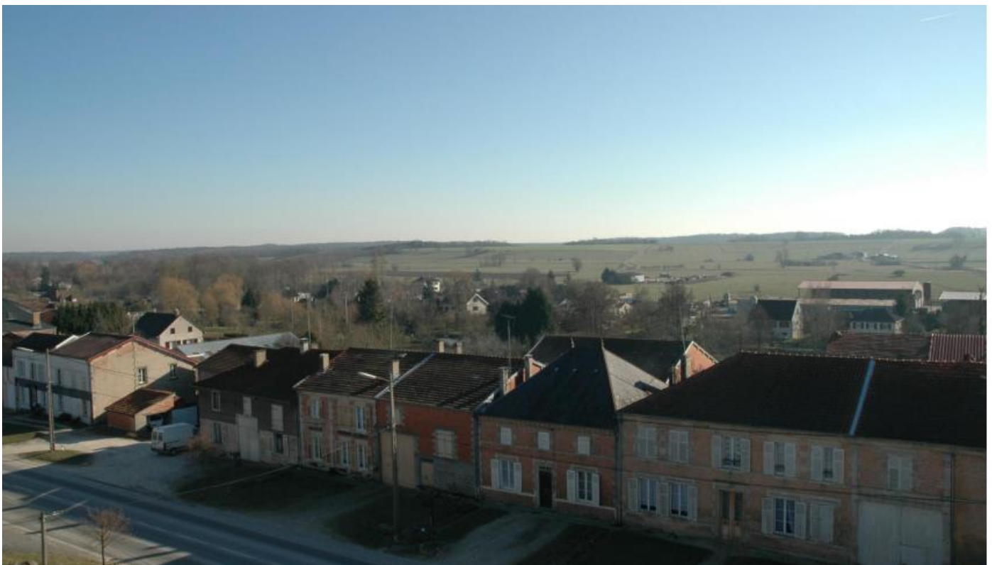
Prise de vue n° 2 : Front bâti cohérent à maintenir et à valoriser. Figure 18: ©UDAP 55
