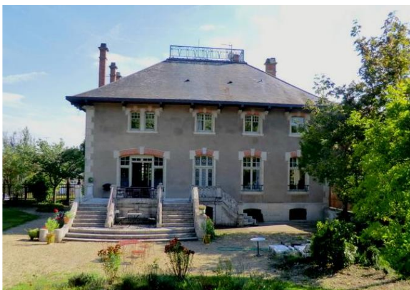
Figure 13 : Villa Teinturier façade arrière © DRAC Grand Est 2011
