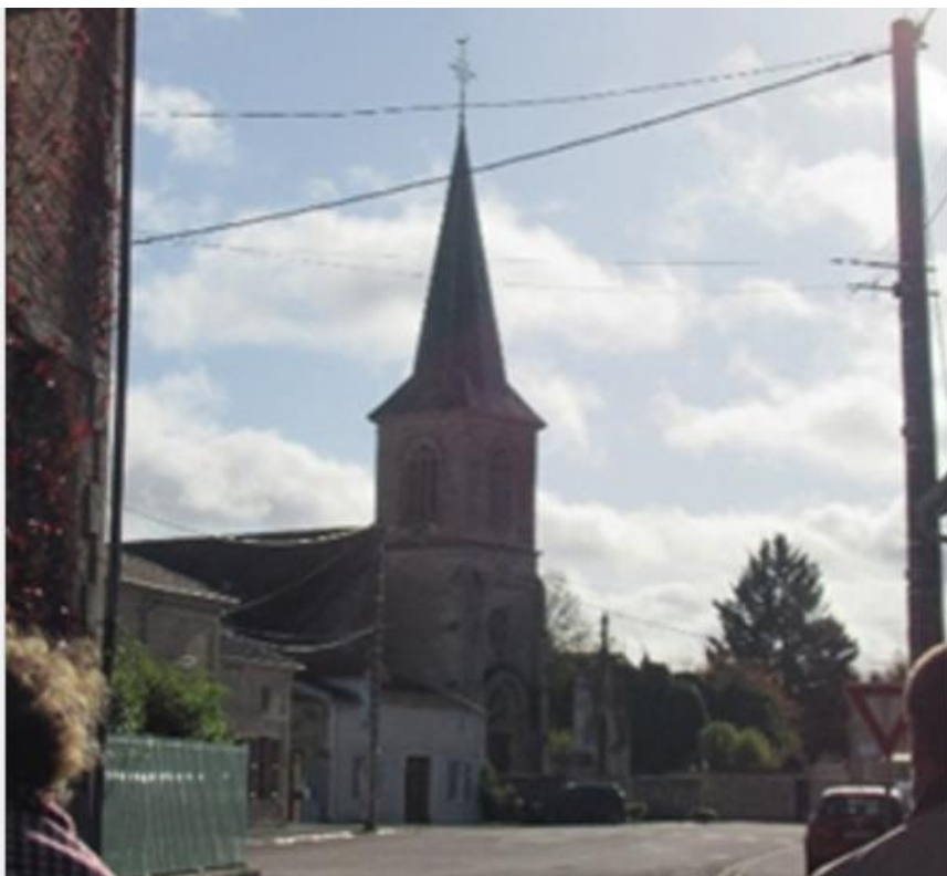
Figure 12 : Eglise Saint Martin sur la place du village
