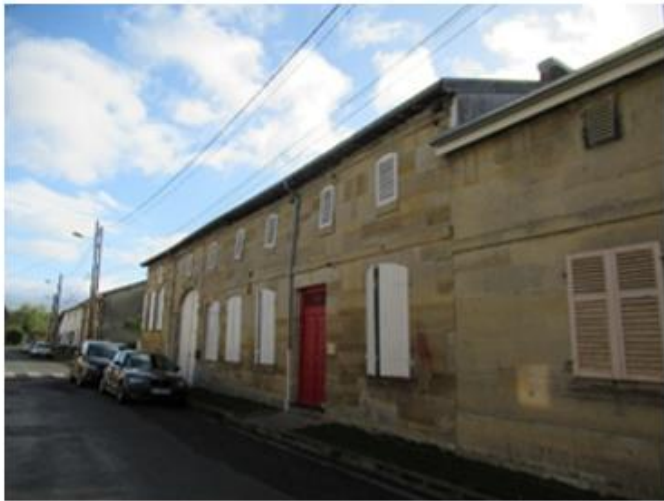
Figure 20 : peinture de volets de façade
