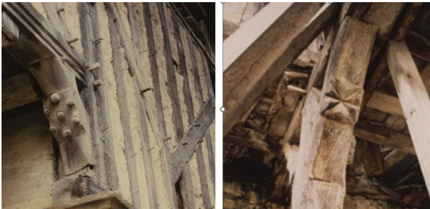
Figure 10 : Ornementations sur les poutres de soutènement de la toiture sur-rue
