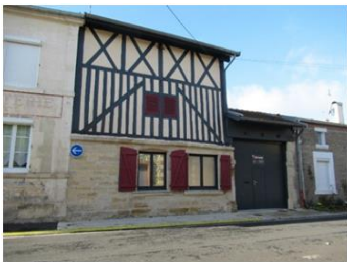
Figure 19 : façade n° : mise en peinture des pans de bois et des menuiseries incohérente avec l'architecture de l'immeuble/ Façade n°2 : Caissons de volets roulants en saillie de la façade
