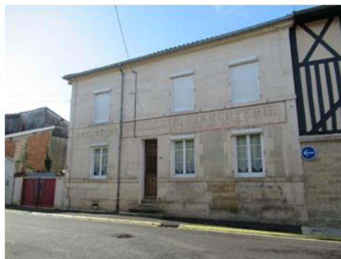
Figure 19 : façade n° : mise en peinture des pans de bois et des menuiseries incohérente avec l'architecture de l'immeuble/ Façade n°2 : Caissons de volets roulants en saillie de la façade
