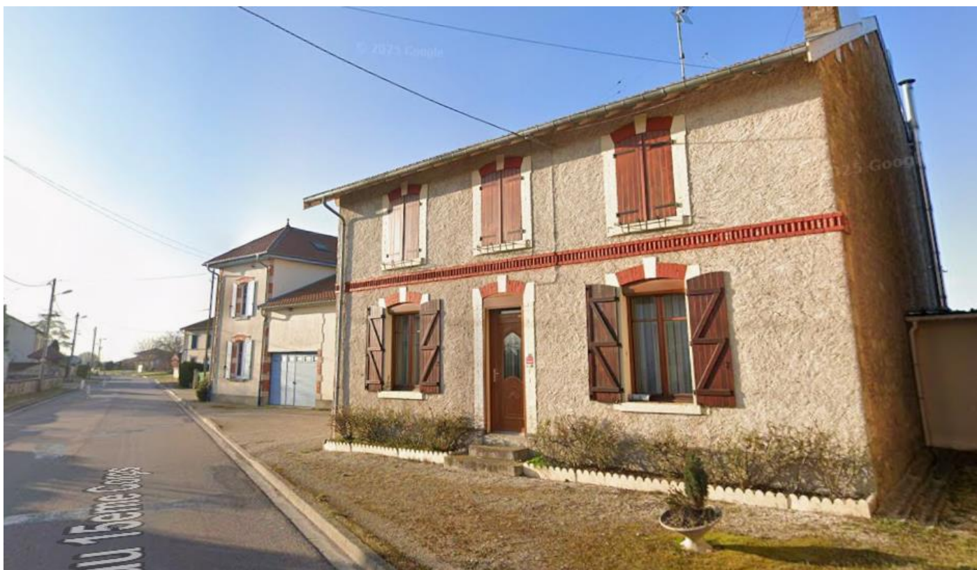
Figure 15 bâti de la Reconstruction (streetview ; 2025)
